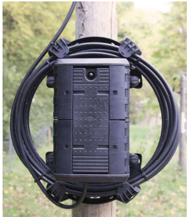
Mise en œuvre avec BPEO T1
