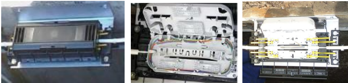
Figure 12 : Point de branchement, exemple TYCO en chambre
