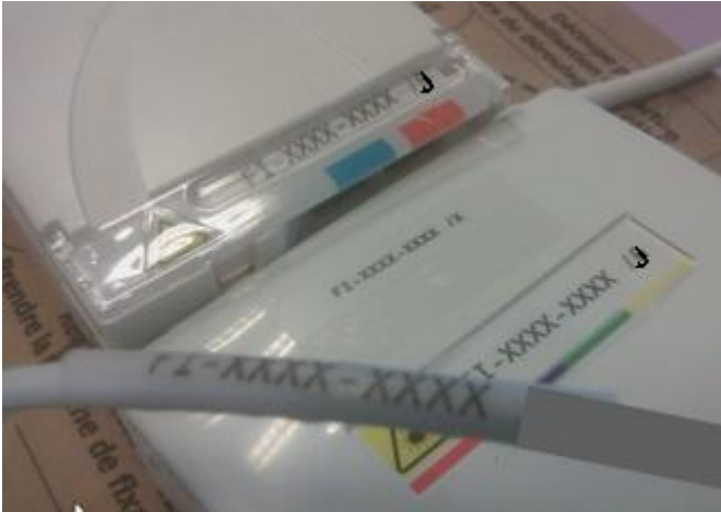
Figure 20 : exemple d'étiquette sur câble de branchement au niveau du PB
