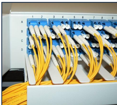
Illustration – repérage sur le Panneau de brassage
