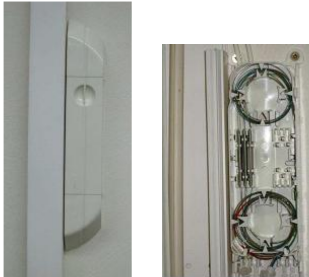
Figure 8 : point de branchement optique : PB Be-Box Acome
