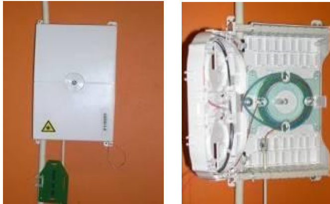
Figure 10 : Point de branchement, exemple TYCO intérieur
